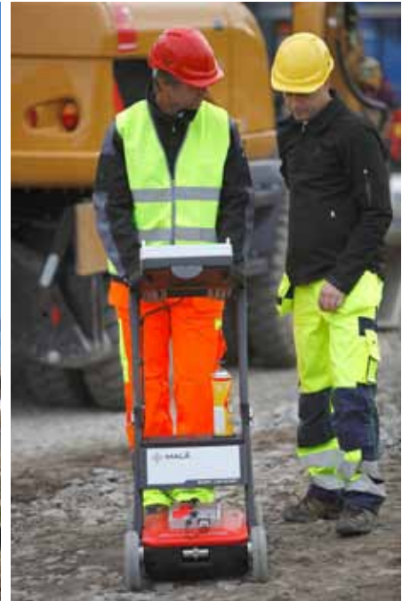
Markradarmätning på byggarbetsplats.
