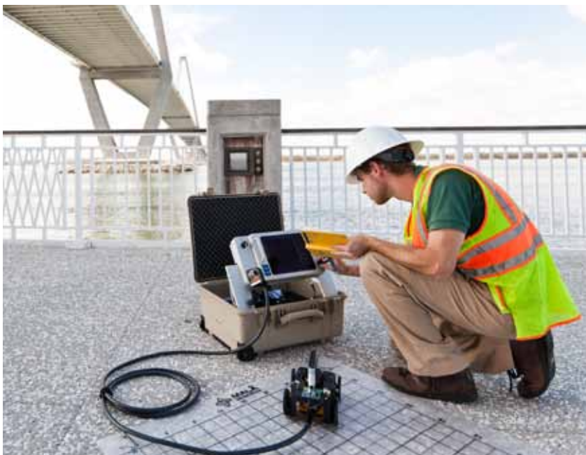
Betongmätning med radar.
