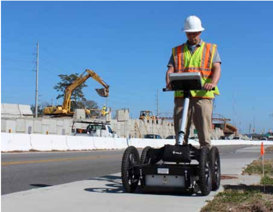
Rör- och ledningslokalisering med markradar.
